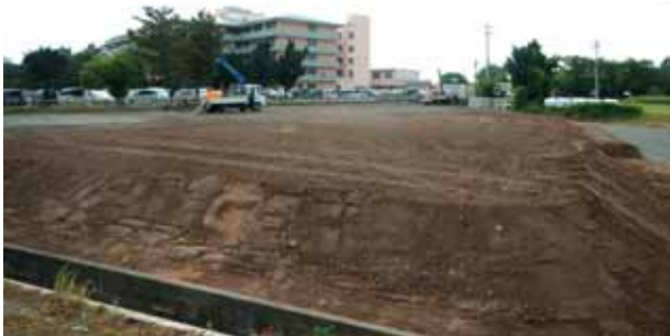
新事務所建設予定地 (熊本市東区戸島2丁目3626番2 敷地面積：2212.19㎡)
